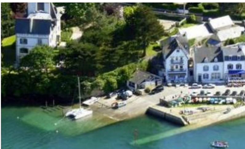
Figure 6 : Aire de carénage submersible de Sainte Marine (Rance-Frémur, 2017)
